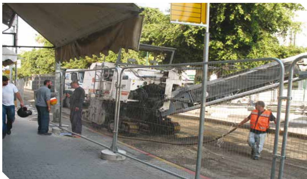
גידור עבודות תשתיות הרכבת הקלה, יצירת מרחב הליכה בטוח להולכי רגל + מעברי חציה. בשרות ירושלים תל אביב
