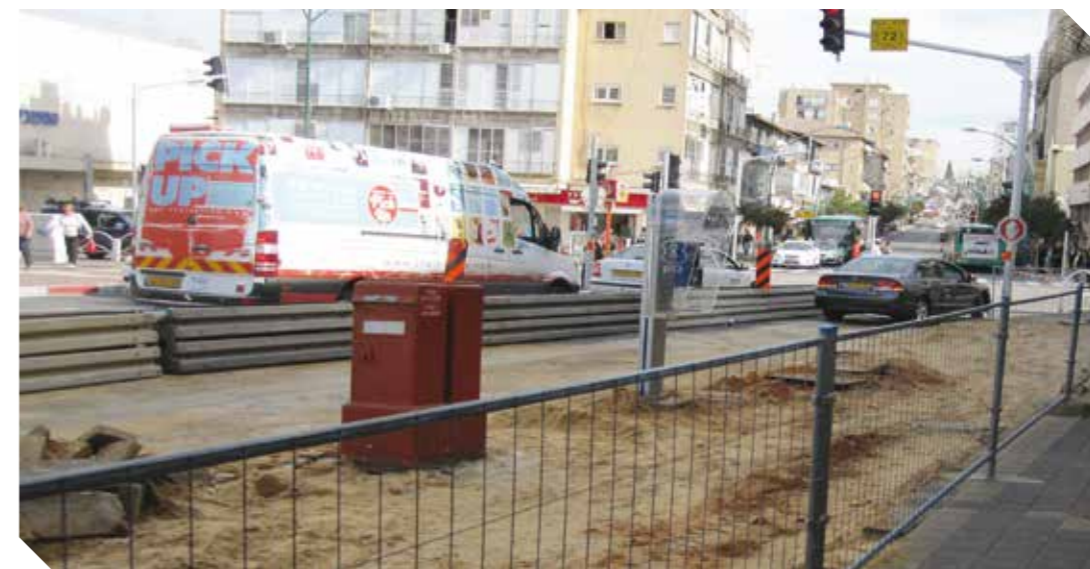
גידור עבודות מדרכה התקנת גדר נמוכה על בסיסים עגולים 45 ק"ג ובסיסי מתכת שטוחים. רחוב רוטשילד ראשון לציון
