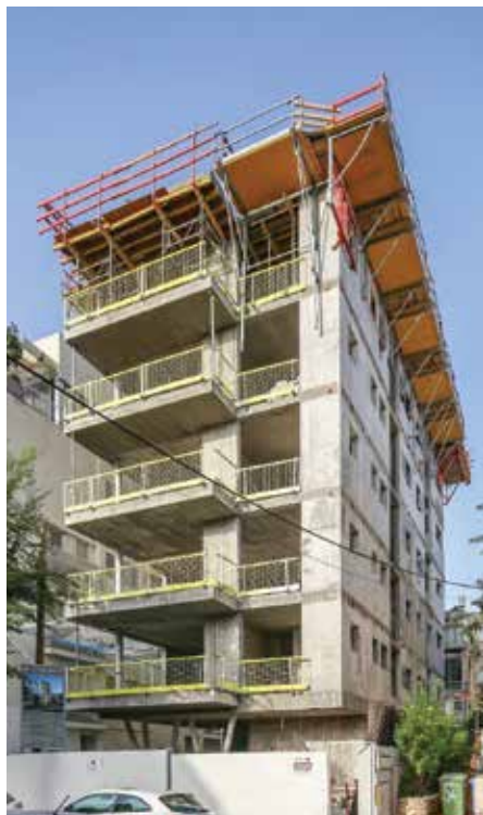
התקנה חיצונית על בסיס זווית לחיבור לקיר
