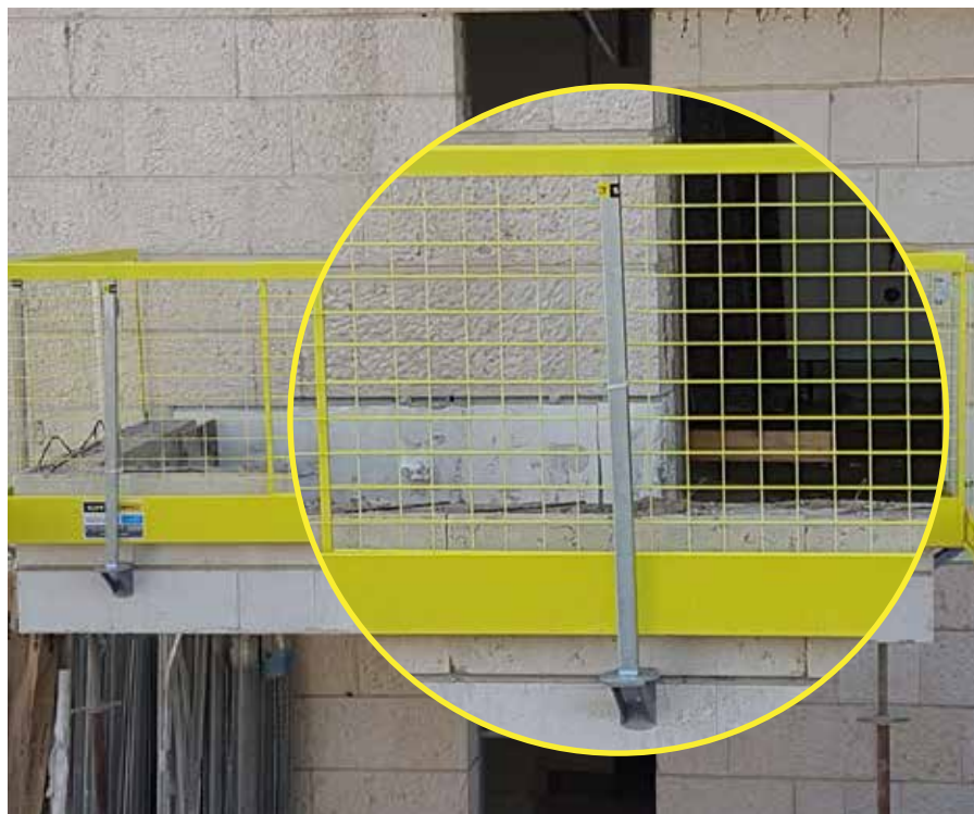
התקנה חיצונית על בסיס זווית לחיבור לקיר
