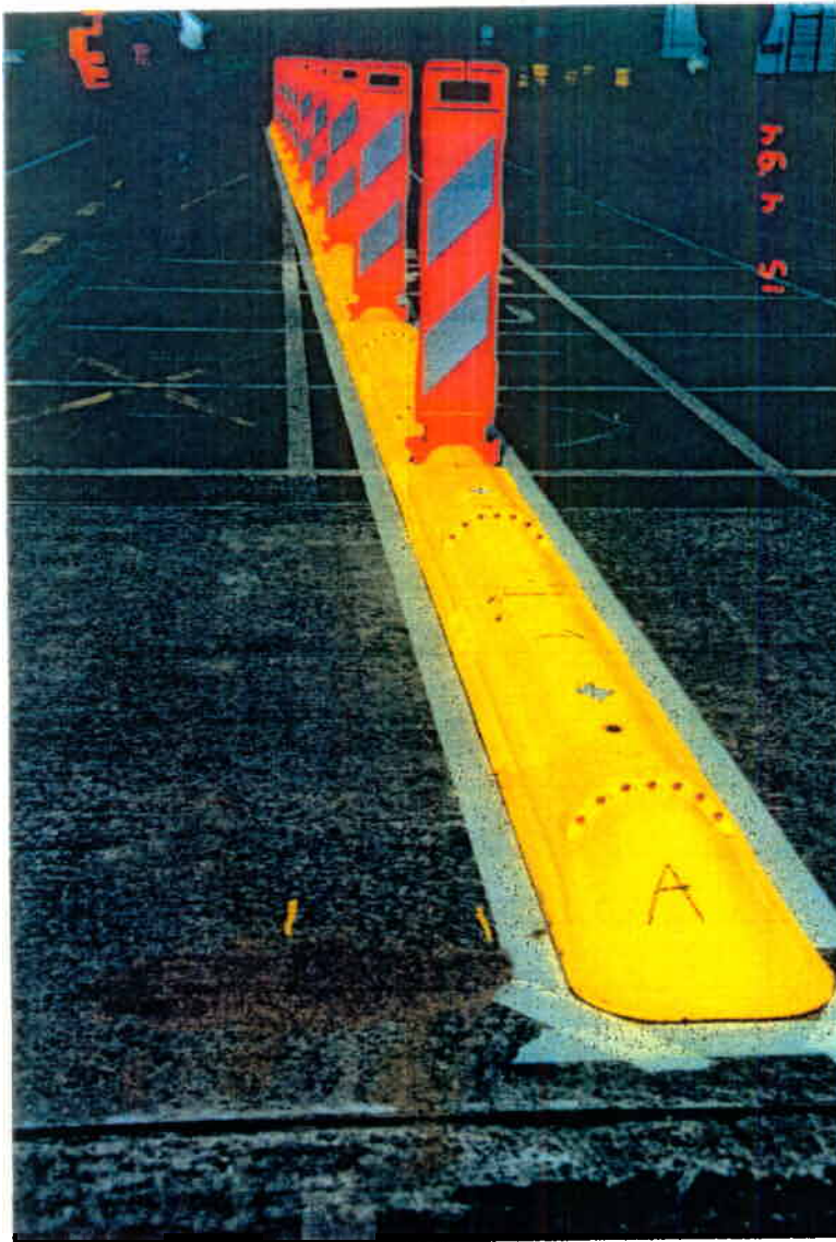
Bild 17: Gesamtsituation nach der 1.º Anfahrt
